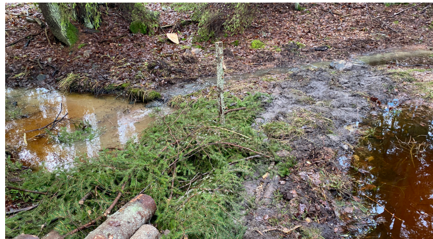
Plywoodplugg i dike under fyllmassor. Foto, Sören Eriksson
