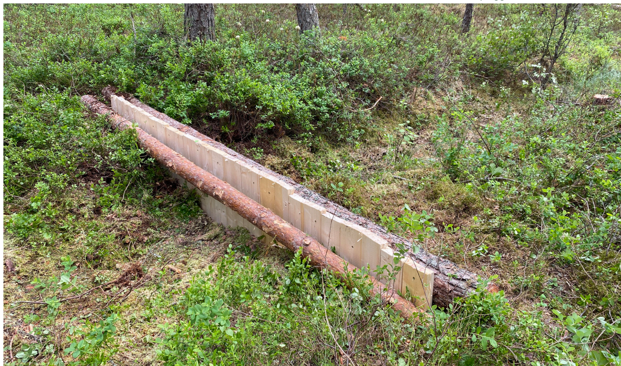
Palissadplugg i dike. Foto, Sören Eriksson
