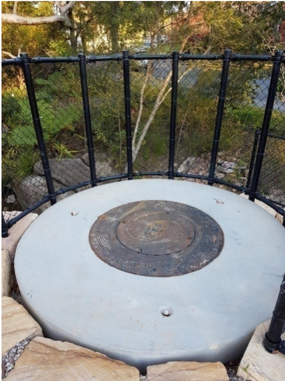
Figur 23. Exempel på en CDS-enhet i Sydney, Australien.
