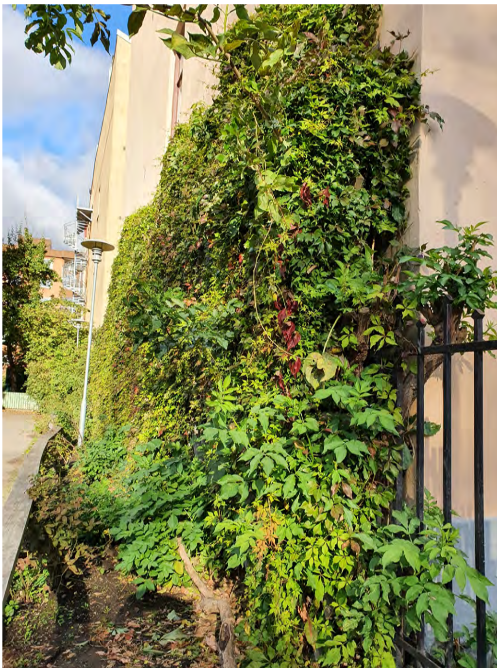
Gröna väggar kan bli ett attraktivt inslag i stadsbilden som främjar den urbana biologiska mångfalden – samtidigt som denna typ lösning kan bidra till att reglera temperatur och hantera dagvatten. Foto: Timo Persson.
