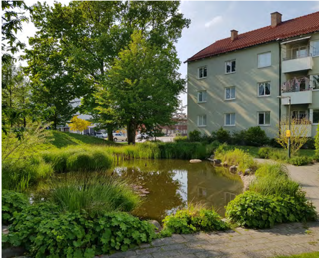
Dagvattendamm till vilken dagvatten leds i öppna dagvattensystem, bostadsområdet Augustenborg, Malmö. Öppna vattenspeglar med skuggande träd ger också svalka under varma dagar. Foto: Timo Persson.
